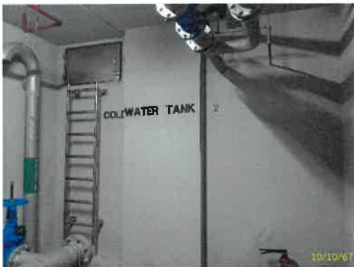
ถังสำรองน้ำใช้ เพื่อการอุปโภค-บริโภค ชั้นใต้ดิน 2
